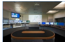
Centre technique et de surveillance à Aigle (CH)
