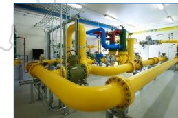
Construction de postes d'interconnexion et de détente
