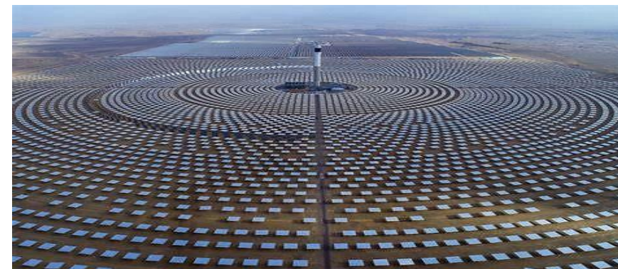
Complexe solaire Noor Ouarzazate, 580 MW, Maroc
