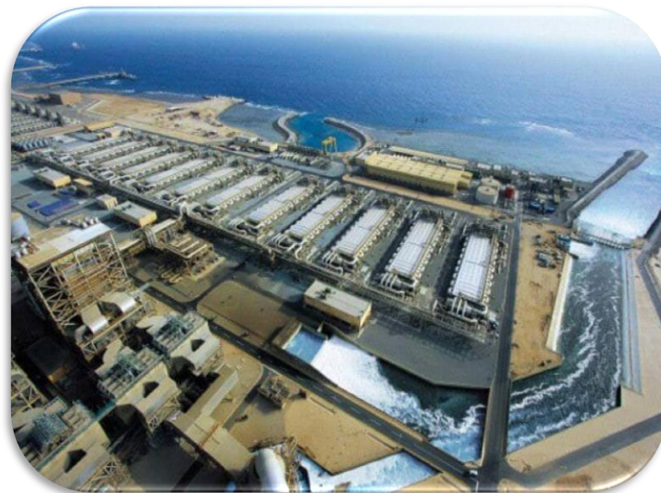
Station de dessalement d'eau de mer à Agadir
