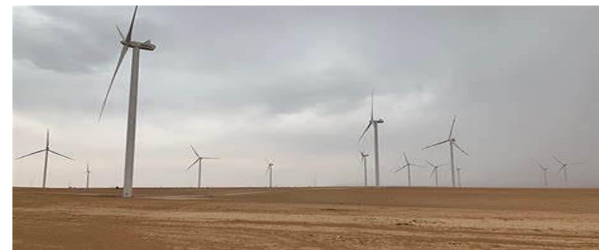
Parc éolien de Boujdour, 300 MW, Maroc
