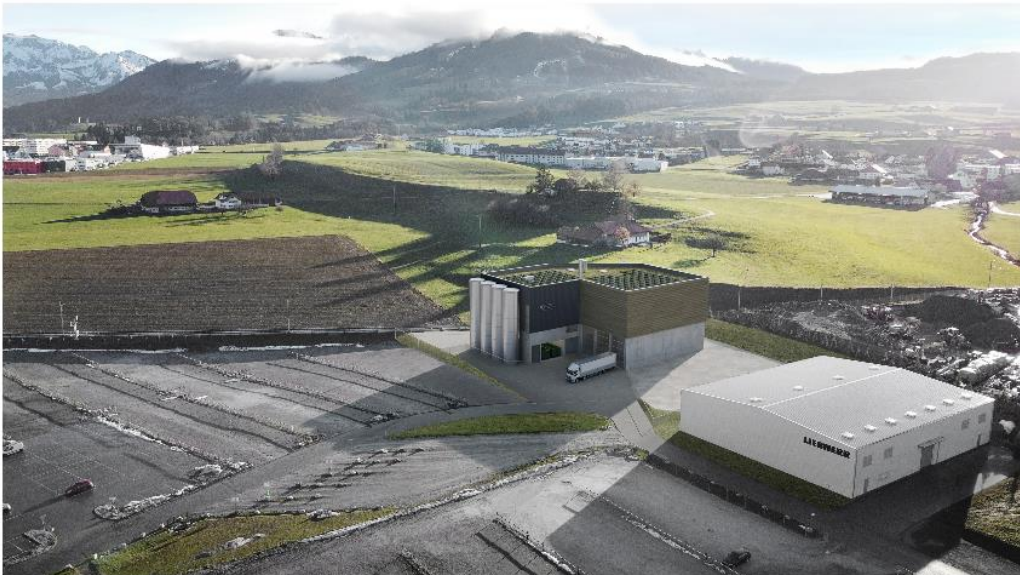
Une photo de synthèse de ce à quoi va ressembler le bâtiment une fois le projet abouti. © Gruyère Energie SA
